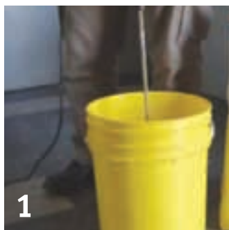
1 PREPARE EL ADHESIVO PARA FIJAR LAS PLACAS
