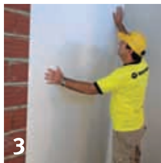
3 PEGUE LAS PLACAS A LA PARED O MURO Y APLOME
